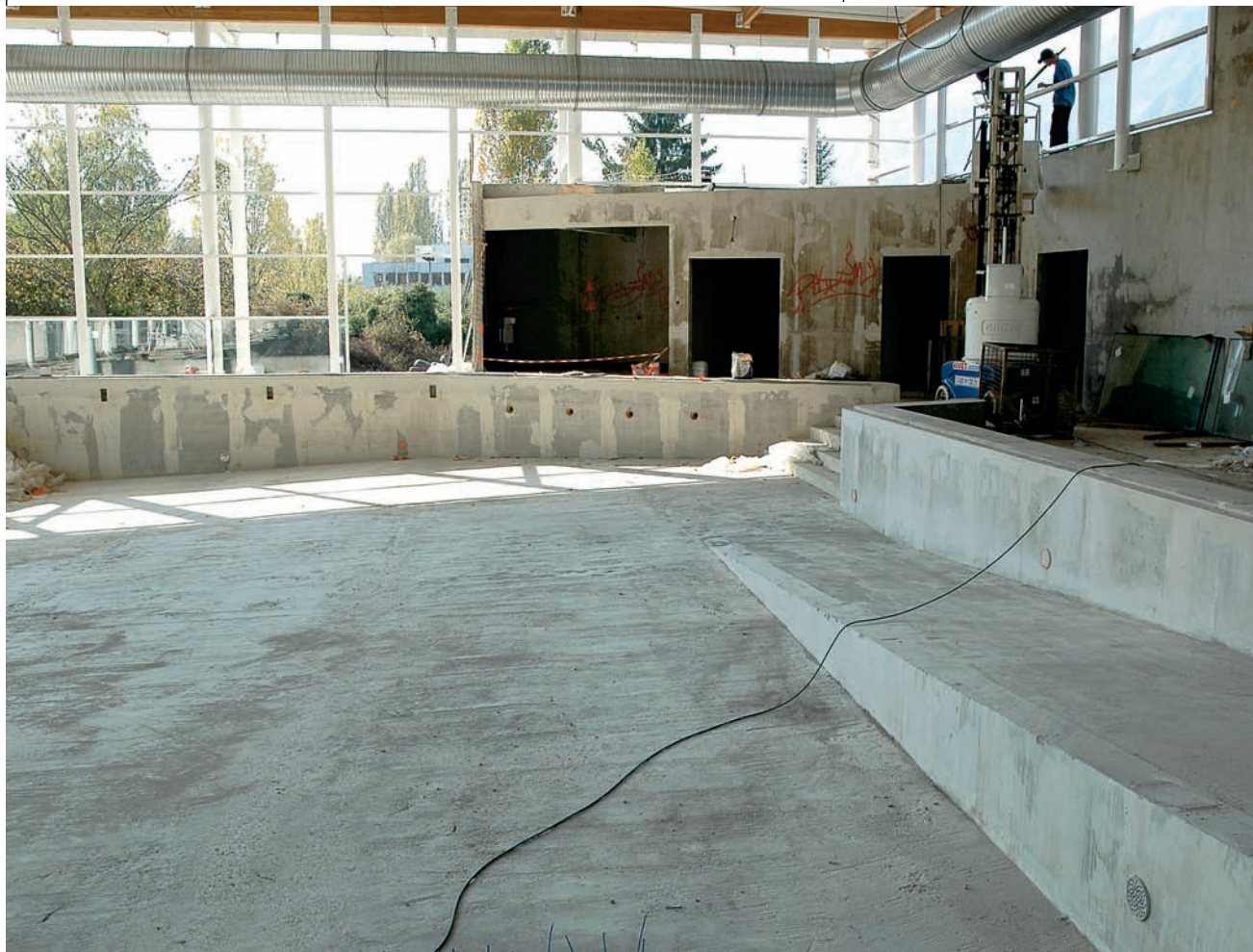
Aménagement d'une rampe d'accès pour personnes handicapées à la piscine de Meylan (Isère).
