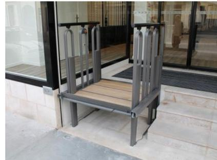
La FlexStep est un produit « 2 en 1 » : à la fois escalier classique et élévateur pour personnes à mobilité réduite, il se transforme à la demande. Il est stable, confortable et esthétique. Il est rapide et souple et permet de franchir une différence de niveau allant jusqu'à 1 250 mm sans attente ou transfert et en tout confort.
